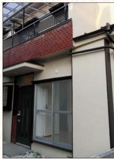
改装後の外観
